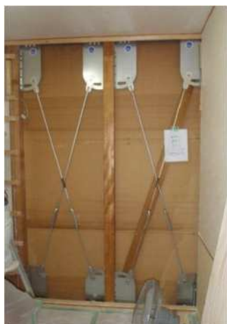
天井、床を解体せずに壁を補強する低コストの改修例 (写真：NPO 法人耐震化アドバイザー協議会)
