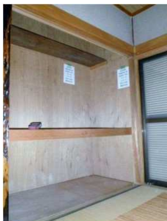
押入や物入の壁を耐震補強した改修例 (写真：半田市)
