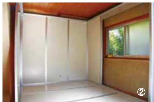
画像①、② 耐震シェルターの施工例 (写真：東京都都市整備局)
