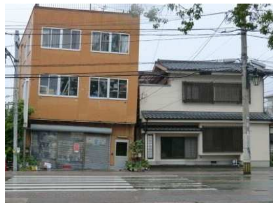
図 液状化による建築物の傾斜
