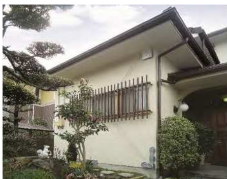
外部から金属のブレースを設置した改修例 (写真：北海道立総合研究機構建築研究本部 建築性能試験センター)
