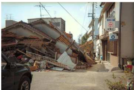
地震により倒壊し道路を閉塞した建築物 (写真：東京都都市整備局)
