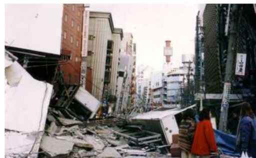
地震により倒壊し道路を閉塞した建築物 (写真：東京都都市整備局)
