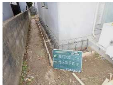
基礎の補強（写真：愛媛県）
