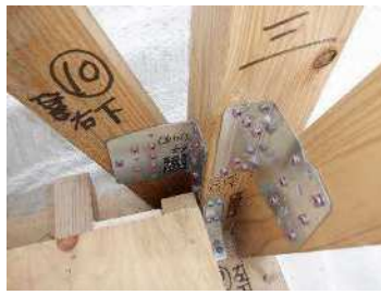
【左】壁の補強（筋交い） 【中】接合部を金物で補強 【右】壁の補強（合板） （写真：熊本県）
