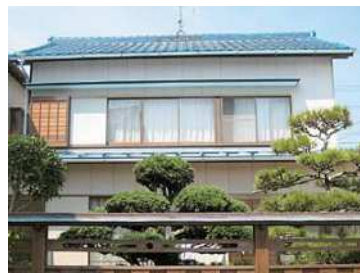
屋根の軽量化（写真：静岡県）
