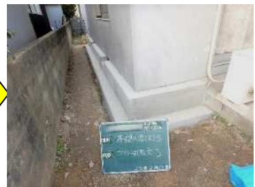
基礎の補強（写真：愛媛県）
