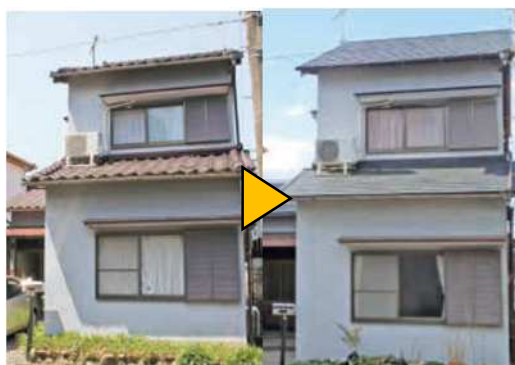
重い屋根から軽い屋根に葺き替えて建物への負担を減らした改修例 (写真：和歌山県)
