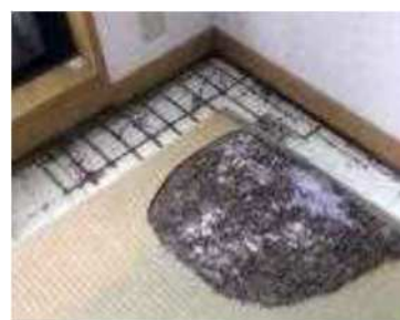
シロアリによる被害（柱脚・小屋裏・畳）（写真：国土交通省）
