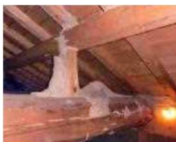
シロアリによる被害（柱脚・小屋裏・畳）（写真：国土交通省）
