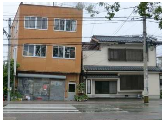
図 液状化による建築物の傾斜
