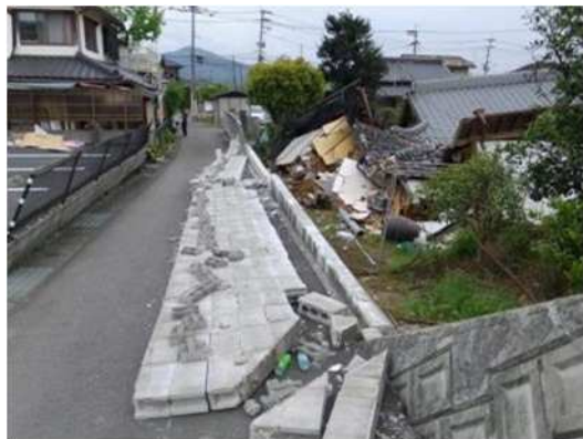
図 ブロック塀の倒壊
