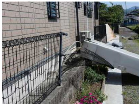
図 給湯施設の転倒
