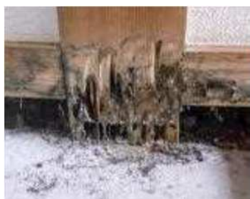
シロアリによる被害（柱脚・小屋裏・畳）（写真：国土交通省）
