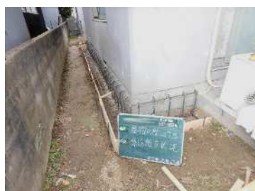
基礎の補強（写真：愛媛県）
