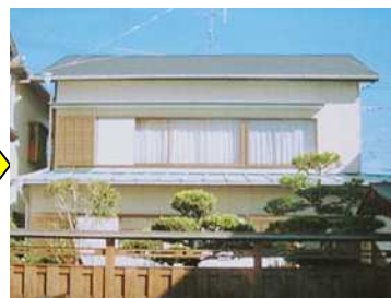
屋根の軽量化（写真：静岡県）
