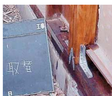
腐朽した柱や土台の交換（写真：静岡県）
