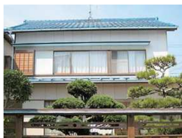
屋根の軽量化（写真：静岡県）
