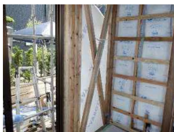
【左】壁の補強（筋交い） 【中】接合部を金物で補強 【右】壁の補強（合板） （写真：熊本県）
