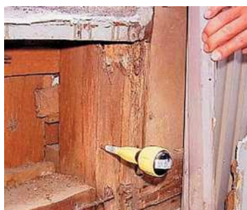
腐朽した柱や土台の交換（写真：静岡県）
