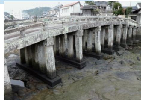
祇園橋は本渡の中心部を流れる町山口川に架かる石橋で、1832年に完成しました。国指定の重要文化財で、観光スポットの一つになっています。石材には下浦で採石された「下浦石」（砂岩）が使われ、下浦の石工たちの手により建造されました。現存する石橋としては全国的にも珍しい多脚式で、当時の石工たちの技術の高さをうかがい知ることができます。
