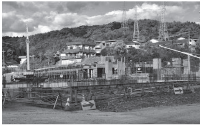
建設が進む複合施設。2020年4月の開館予定。
