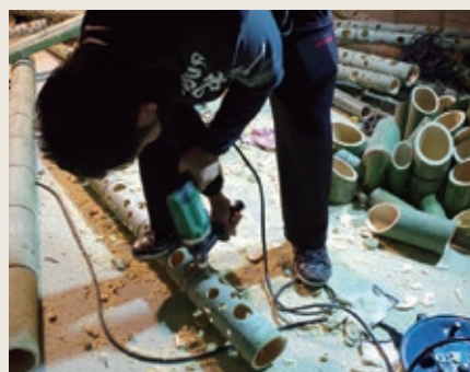
▲ドリルで穴を開ける作業は腰にくる
