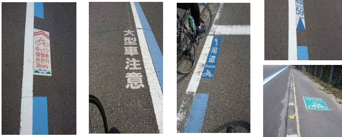
▲整備事例【しまなみ街道サイクリングロード】
