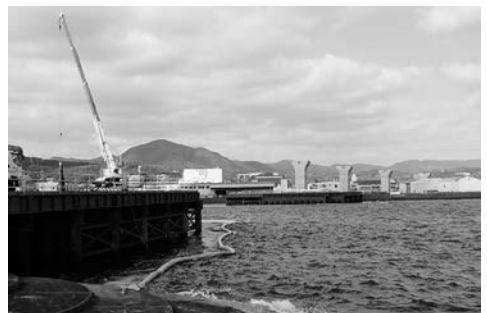
▲急ピッチで進む本渡道路
