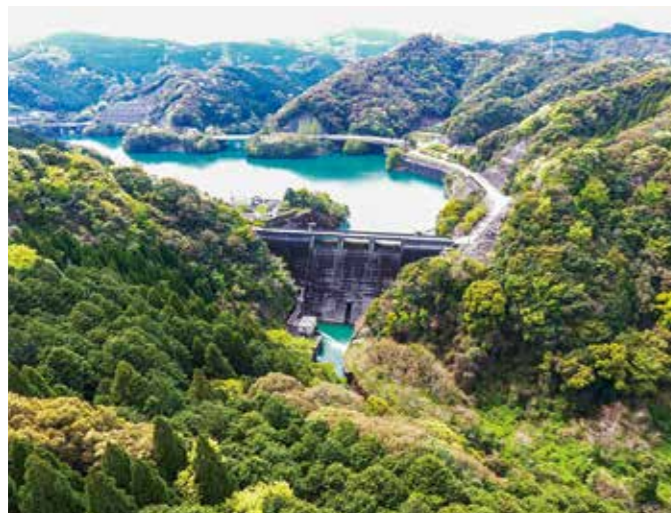
亀川ダム（栞宇土町）
