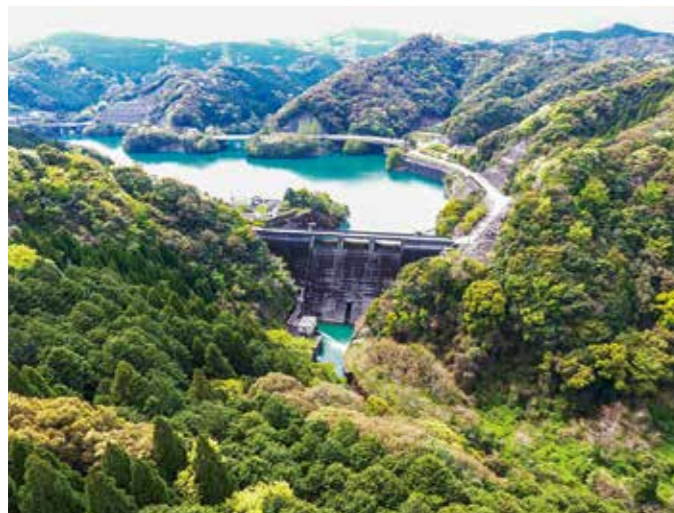
亀川ダム（栢宇土町）
