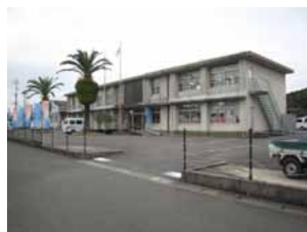
本庁から約 2 km 離れた場所にある別館（経済部・建設部・教育部）
