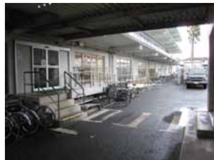
本館と新館の間が階段であるため、往来に不便となっている
