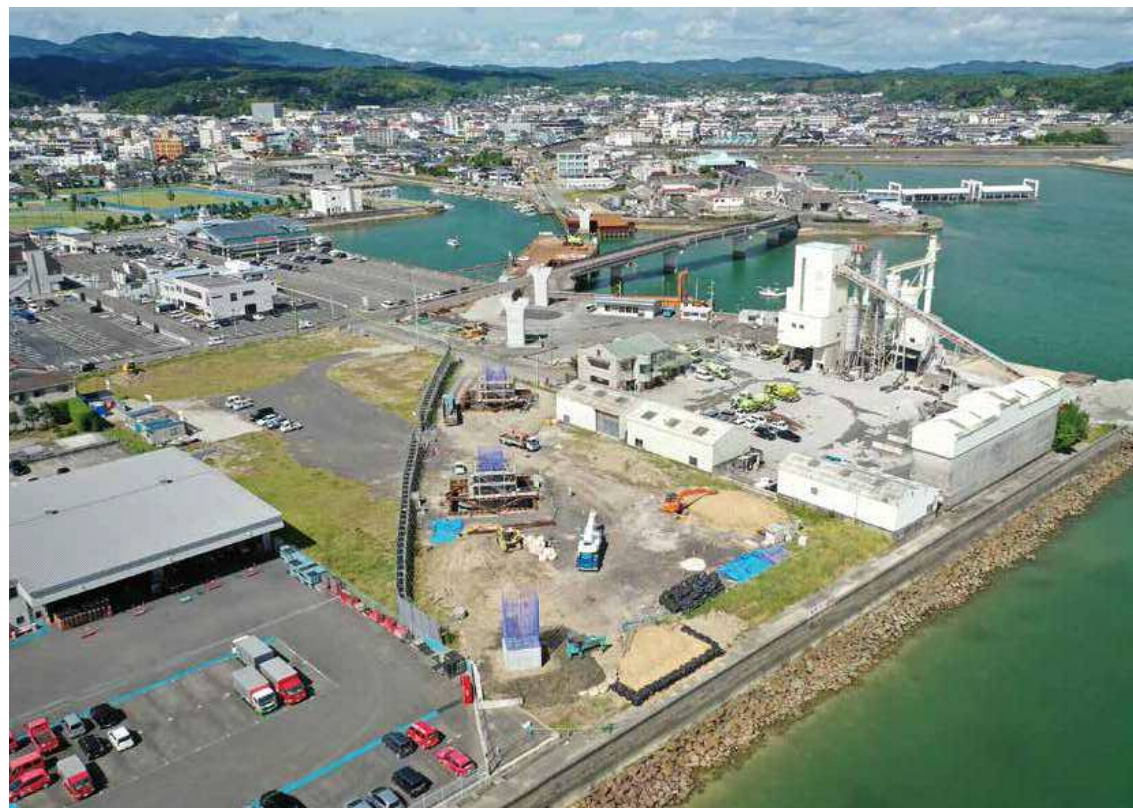
▲(仮称)第二天草瀬戸大橋の工事進捗状況(令和元年10月撮影)
