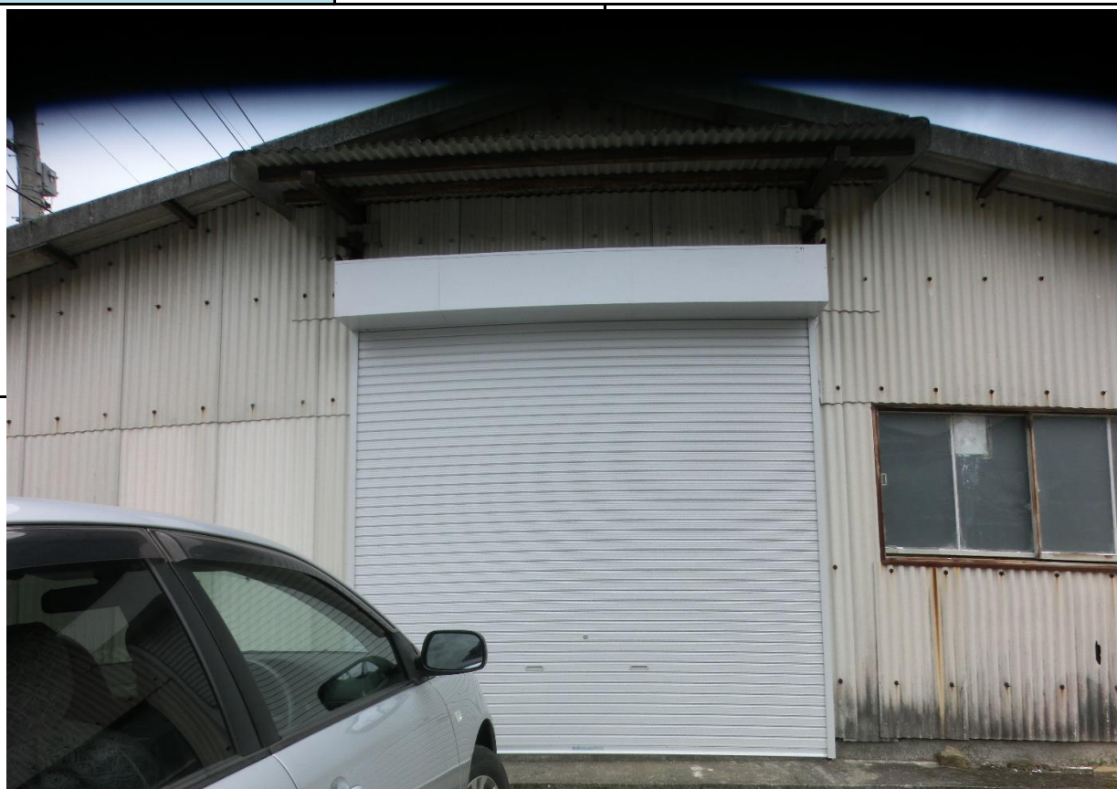
① 倉庫出入口シャッター修繕
