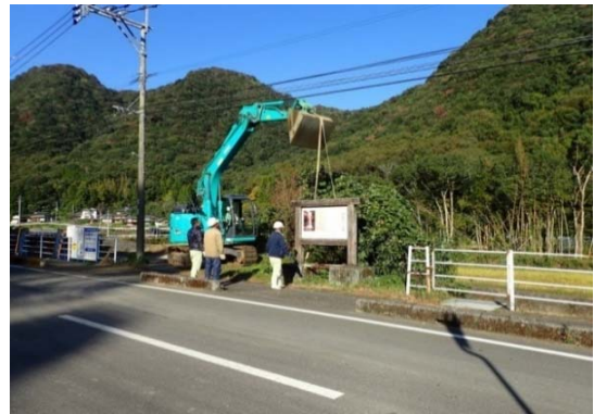
滝案内看板移設補修工事
