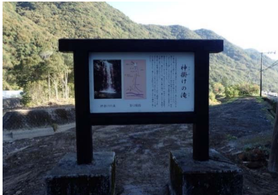
滝案内看板移設補修工事
