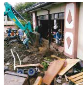
▲重機を使うほどの土砂の量
