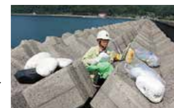
消波ブロックの隙間のごみを回収▶
