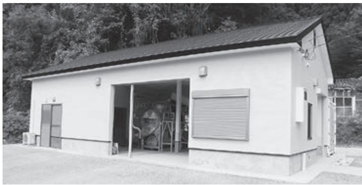
▲完成した有害鳥獣処理施設
