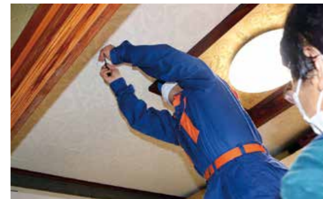
▲消防団員が住民宅へ火災警報器を設置
