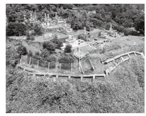
▲地すべりが発生した大矢崎地区
