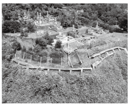
▲地すべりが発生した大矢崎地区
