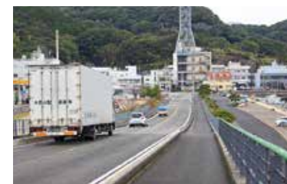
▲8月下旬から通行止めとなっていた同橋を通行する車両
