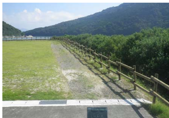
木製の転落防止柵
