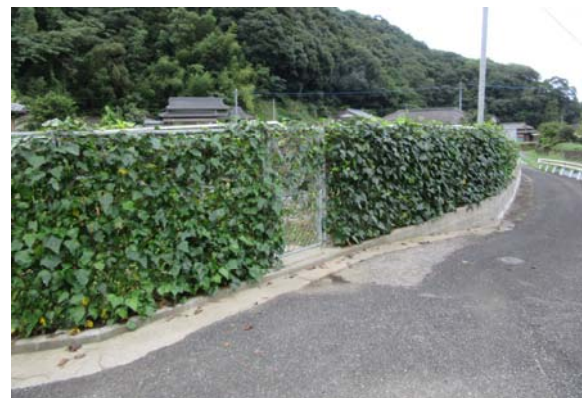
生長した状況（令和元年9月撮影）
