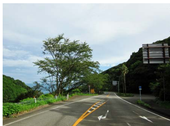
天草西海岸[国道 389 号沿線] 除伐後
