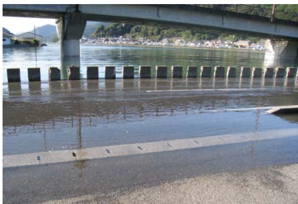
整備前（高潮による冠水時）
