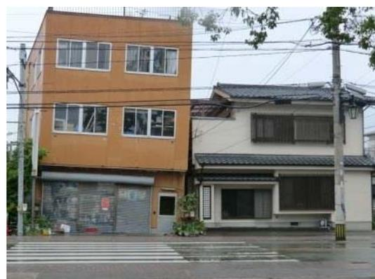
図 液状化による建築物の傾斜
