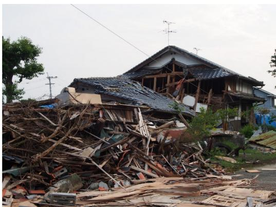
また、昭和 56 年 6 月以降建設のうち倒壊した木造建築物の被害要因のほとんどは、柱と梁等の接合部が平成 12 年 6 月以降の建築基準法の規定による仕様を満たしていなかったためであると分析されています。接合部以外で被害を大きくしたと考えられる要因としては、地盤変状、隣接する建築物の衝突、シロアリによる木材の劣化がみられたとされています。
