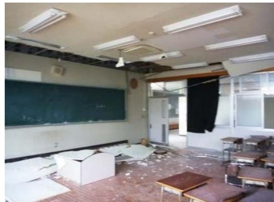
図 天井の脱落（校舎）
