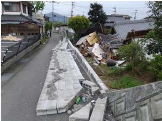
図 ブロック塀の倒壊
