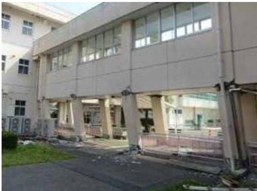
図 渡り廊下の倒壊（校舎）
