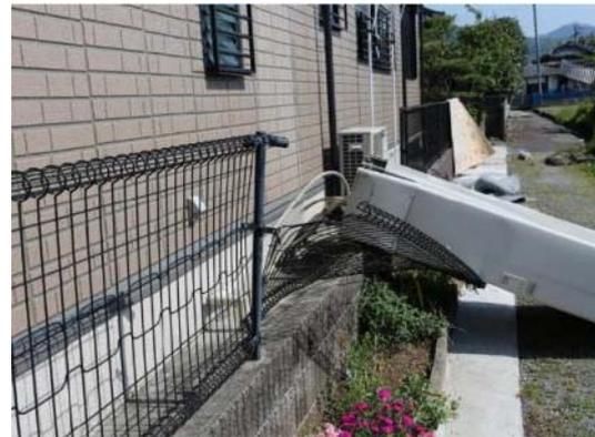
図 給湯施設の転倒
