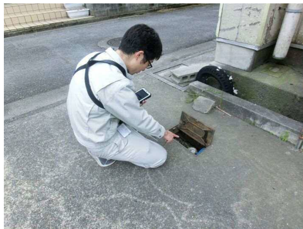
写真 2-7-1 水道メーター検針状況
