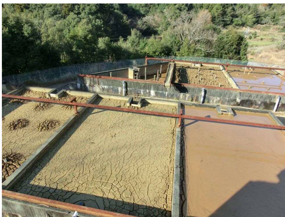
写真 2-4-2 栢宇土浄水場の天日乾燥施設
