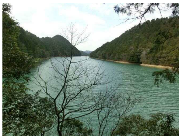
写真 2-3-1 第 2 ヤイラギダム
