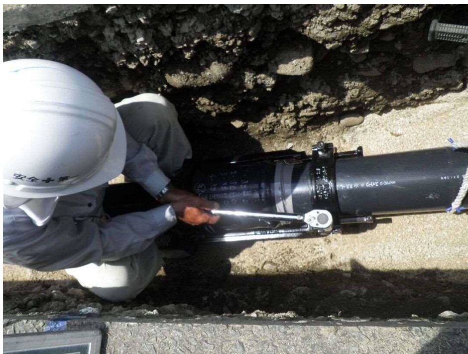
写真 4-3-1 配水管布設状況
