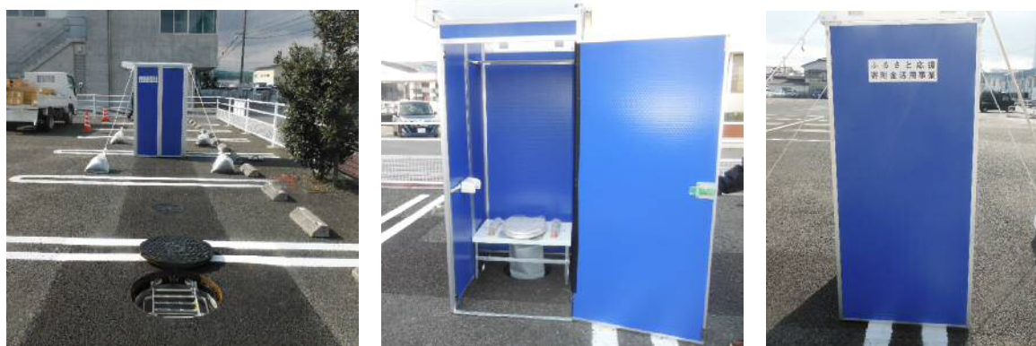
マンホールトイレ設置状況（市民センター駐車場）
