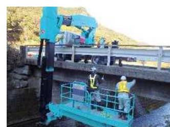
橋梁の定期点検状況(4)
