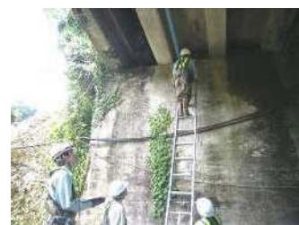
橋梁の定期点検状況(2)
