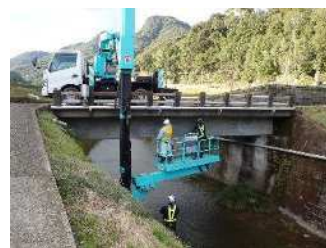
橋梁の定期点検状況(3)
